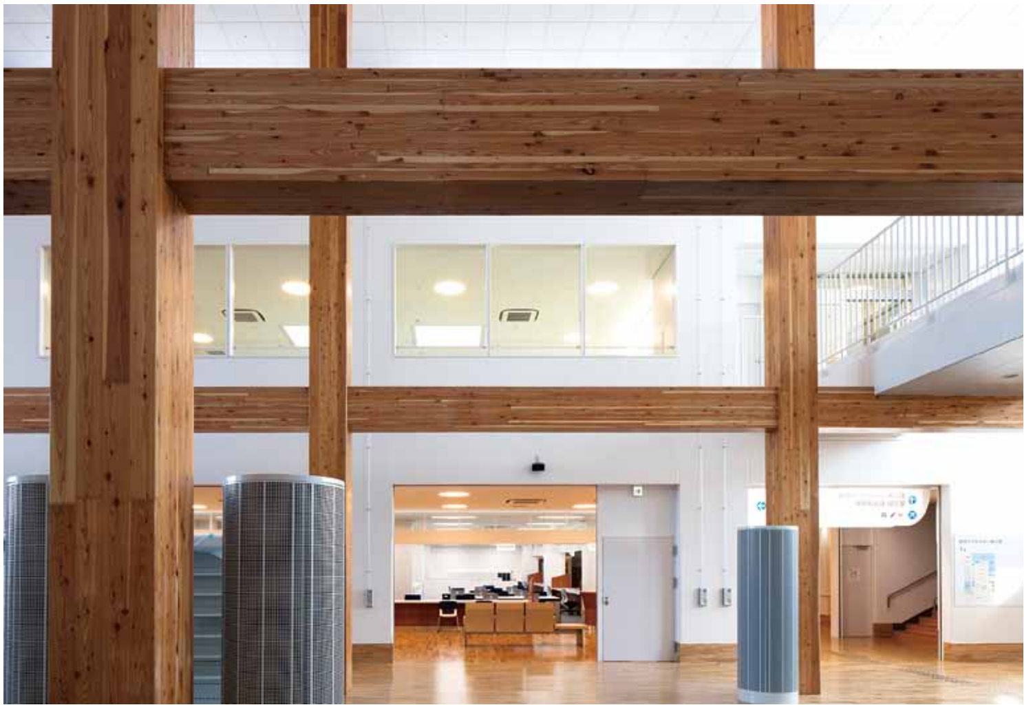
みなさん通りよりケアセンター側をみる：東西のエントランスからみなさん通りに入る、いわば大きな風除室。みなさん通りを境に病院とケアセンターに分かれる稼働時間が異なる施設管理上の区分や、救急感染診察室に直接アプローチできる、交錯しない動線計画を実現。施設相互連携を視野に、2階ブリッジで連絡している。大屋根を支える木フレームはペイマツによる耐火集成材
