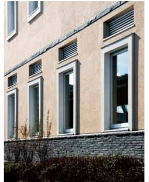
湿式外断熱工法による外壁と稲井石(石巻産)小端積み
