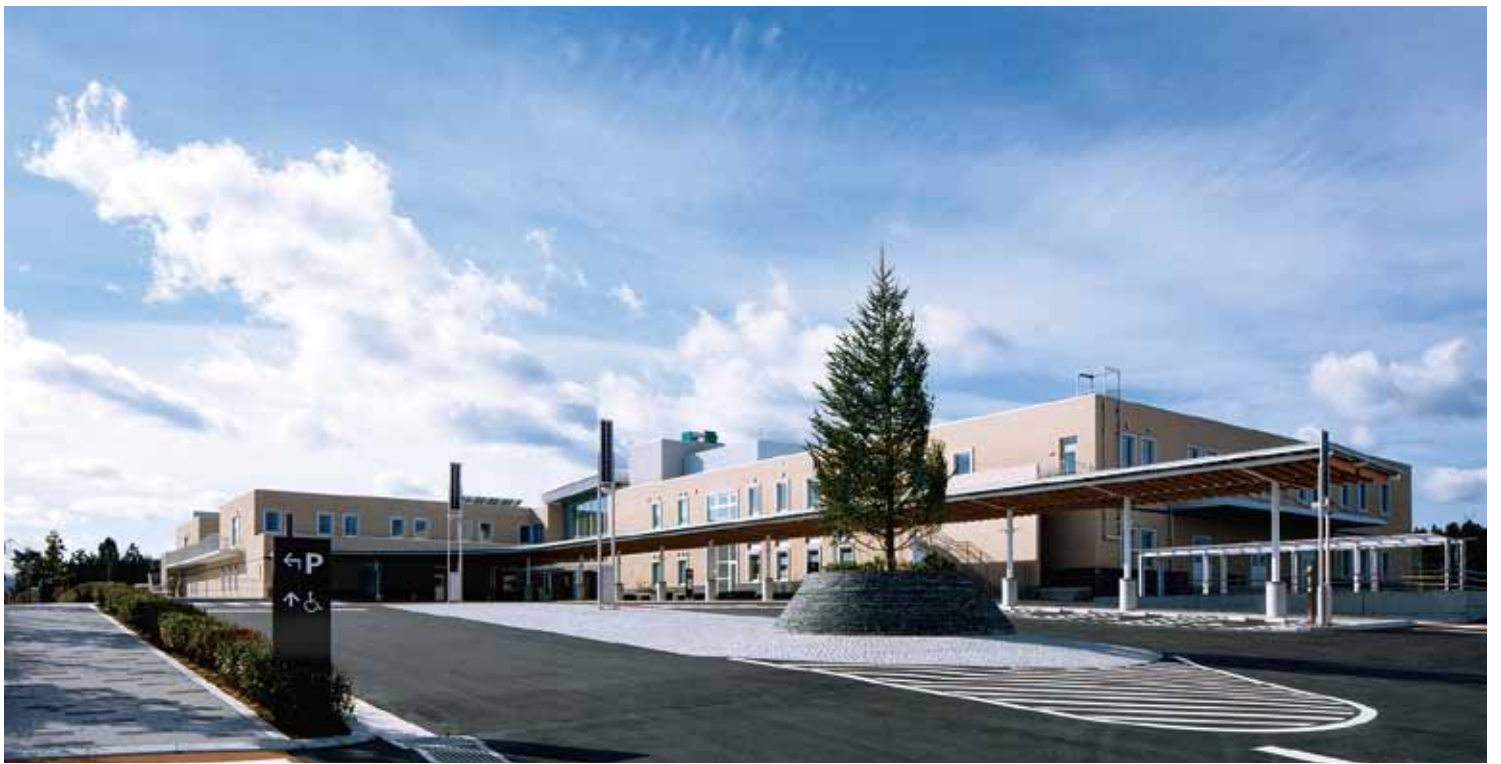
東側全景：ケアセンターと病院をダイナミックに繋ぐキャノピー。軒天井ルーバーに南三陸産材の杉集成材を活用。モミのシンボルツリーは元の地山の守り神
