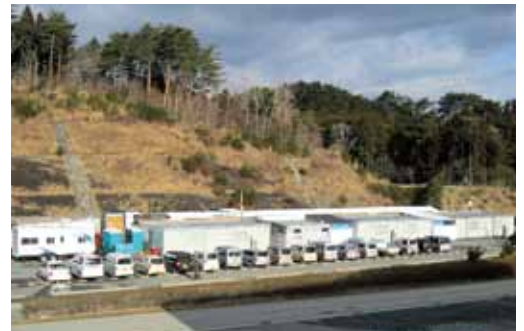
公立志津川病院仮設診療所開設(※1)
