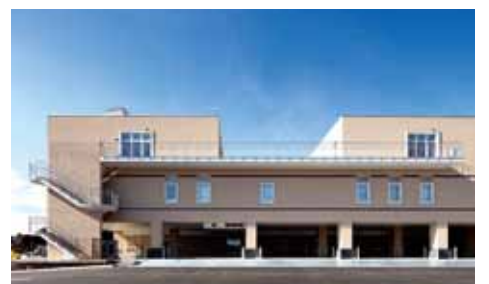
病院棟ピロティ：緊急時のトリアージとしても活用可能
