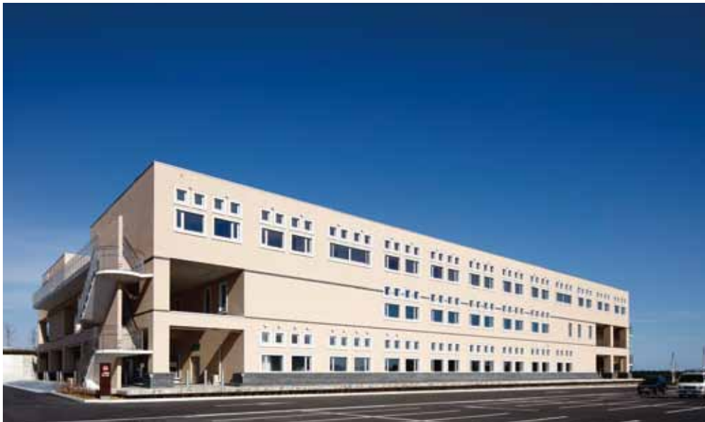
南側全景：白い額縁とボーダーは長大なファサードを周辺の住宅スケールに近づける(ブレイクダウン)配慮
